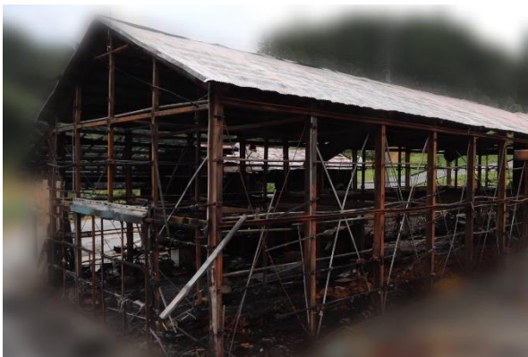
全焼した倉庫
