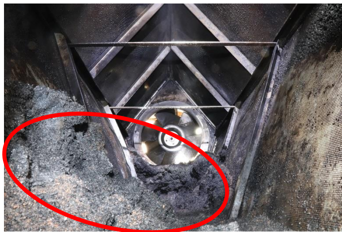
堆積している藁くず（出火部分内部）
