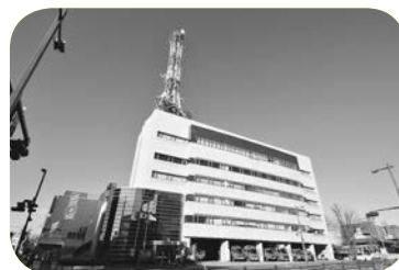
消防本部庁舎
