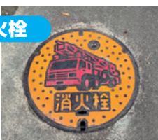
地下式消火栓
