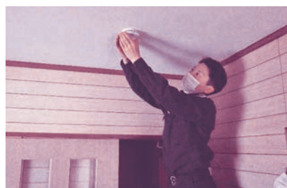
住宅用火災警報器を取付けている様子
