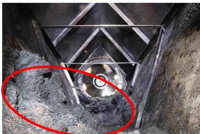
堆積している藁くず（出火部分内部）
