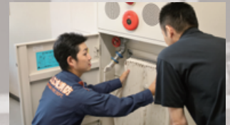
写真:消防用設備等の検査
