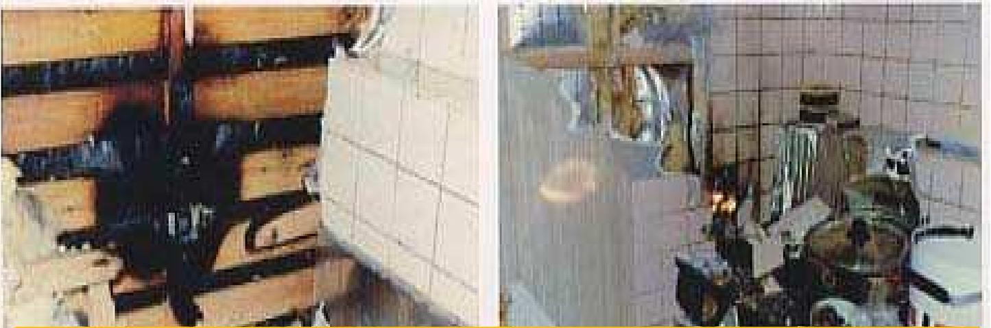
台所でコンロを使い煮炊きをしていたところ、輻射で蓄熱したステンレスからの伝導過熱による内部木材の**低温発火**で、タイル張りのコンロ側面壁の内側から出火した事例
